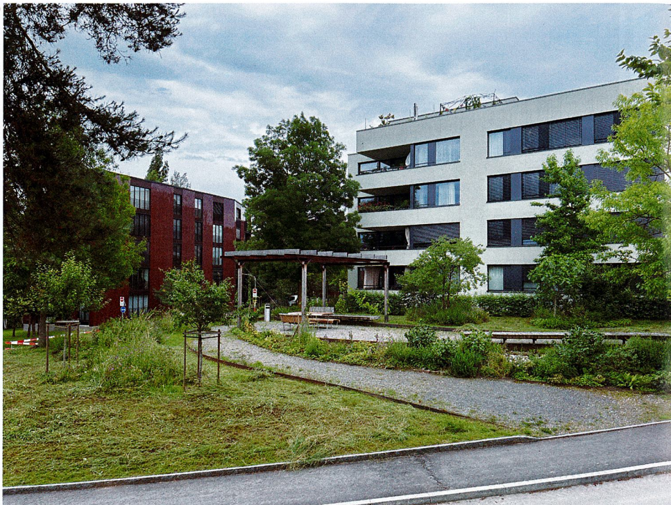
Vor- und nachher: Zusammen mit 15 Bewohnenden der Siedlung am Katzenbach in Zürich pflanzte das Gärtnerteam an einem Samstag rund 120 Pflanzen für einen Naschgarten (Bild links). Im dritten Sommer können die Bewohnenden bereits Obst und Beeren ernten (Bild rechts).
